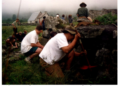
Réfection d'une construction de berger. 24 juillet 1998. Camp de Payolles.
