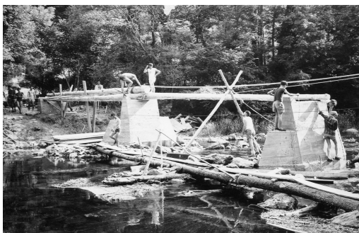
Pont du camp national des patrouilles. 1965
